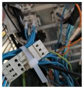
5) 用扎线带将松绳开关线缆固定在控制柜内。
